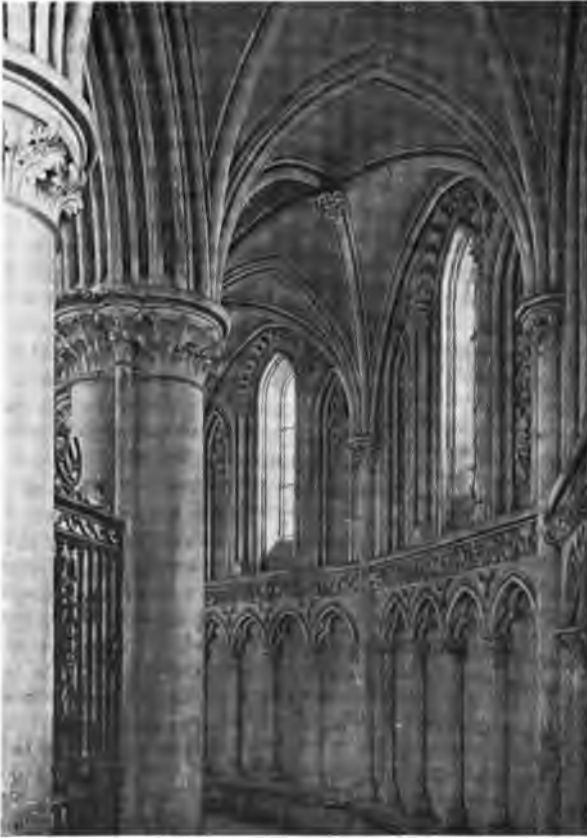
Fig. 156. -- Voûte du collatéral à l'église de Norrey (Calvados). Affinement des détails de l'architecture au xiv e siècle.
